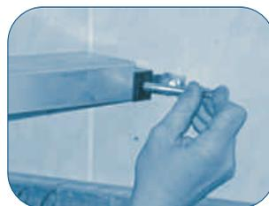
7.....Ajustar o comprimento dos esquadros de fixação do motor ao tecto, de modo a ficar nivelado, respeitando as cotas mínimas aconselháveis, de 50 mm entre a calha e a porta seccionada. Fixar os esquadros ao motor e ao tecto;
